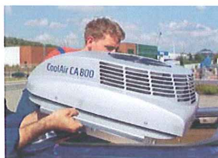
Utiliser les points d'encrages existant pour installer le nouveau climatiseur de toit.
