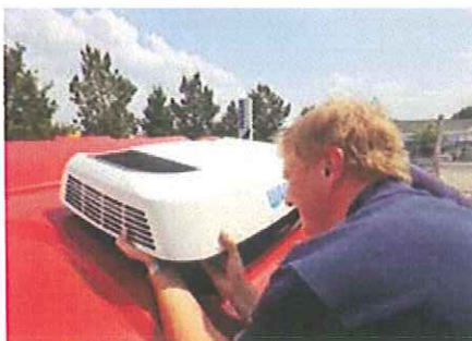
Finition parfaite : l'installation du nouveau climatiseur de toit
