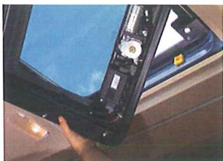
Préparation : démontage du lanterneau existant
